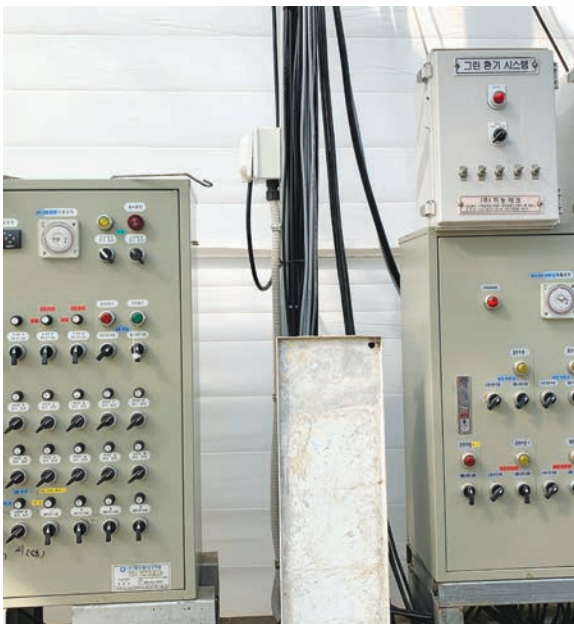
정원농장에서 사용 중인 스마트팜 설비들로 에너지 절감을 위한 공기 순환통(오른쪽)과 에너지 절감을 위한 콘트를 부스, 실내 환경 제어시스템과 복합환경제어 시스템이다.
