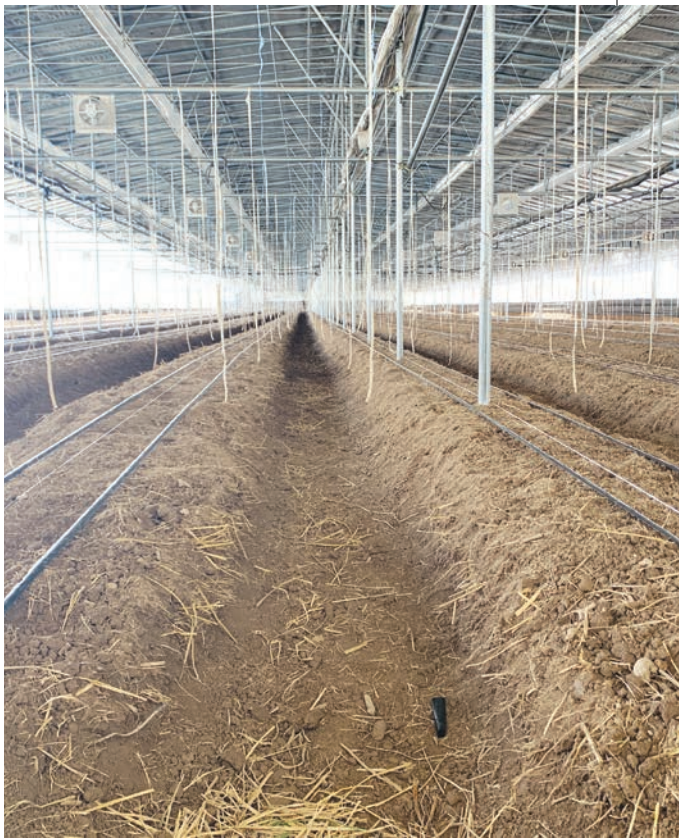
기존 시설에 스마트팜을 도입하여 단동형 시설에 흙을 남겨두었다. 고추 모종을 심기전 관수와 양액을 위한 시설이 정비된 모습(좌)과 시설외관(우).
