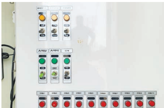
노지 스마트팜 영농 모델 개발 사업에 참여해 농작업의 편의성 향상을 목표로 노지 작물에 센서, 자동관수·관비 장비 등을 적용했다. 사진은 스마트팜 관수제어 콘트롤러.
